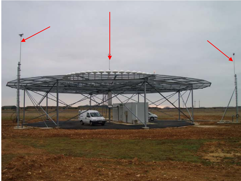
VOR doppler avec capteurs 45° et 315°
